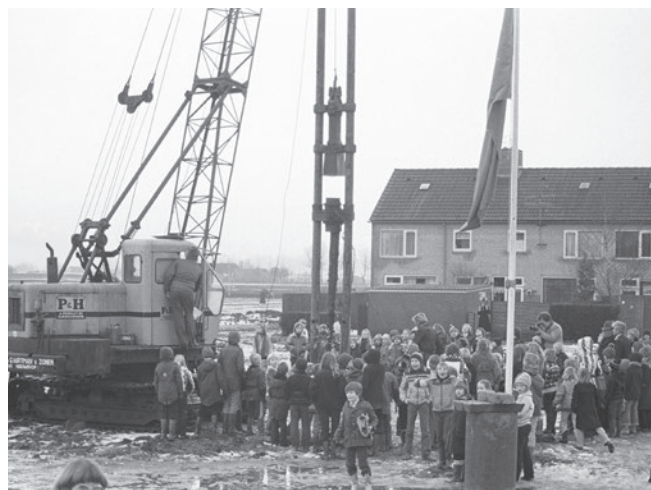
Eerste paal slaan De Kuil 2 ( januari 1979)
