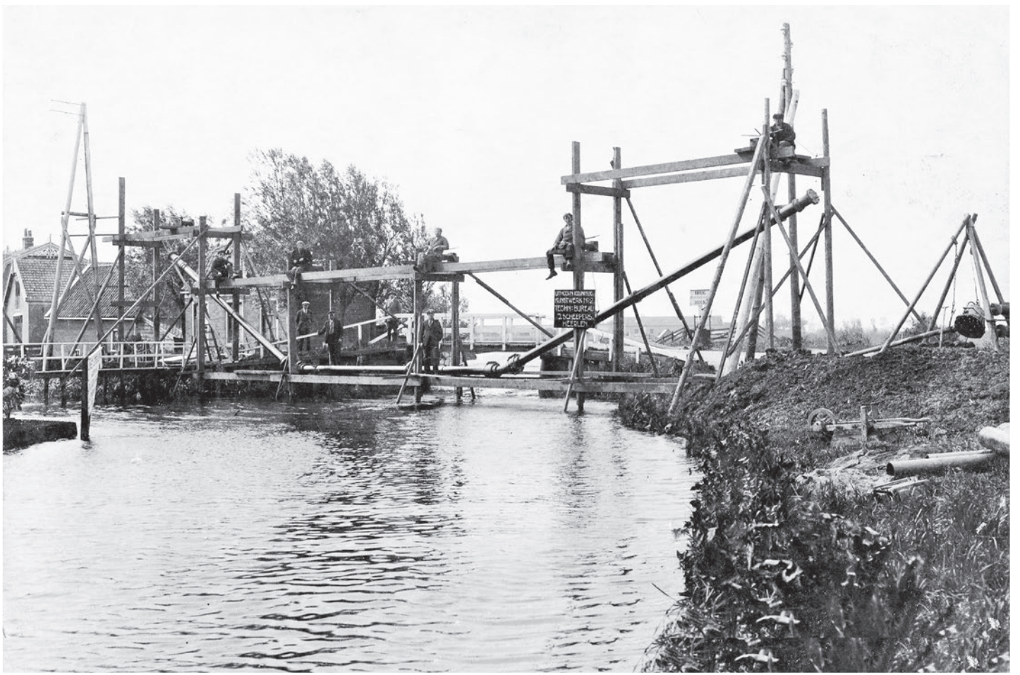
Aanleggen van de waterleiding Kwakelsepad (1926)
