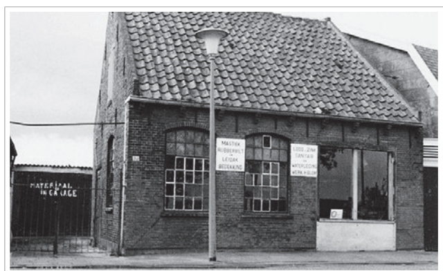
Oude werkplaats Nieuwveen (1971)
